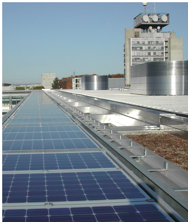
Photovoltaik-Anlage der ETH Hönggerberg
